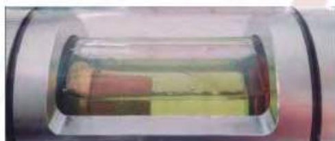
Presencia de humedad
